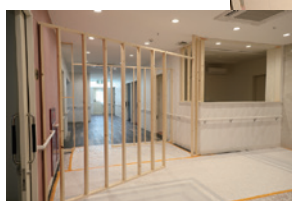
ゾーニング工事の様子
